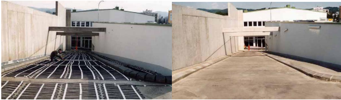
Şekil 2. Betonun iletken kablolarla ısıtılması
