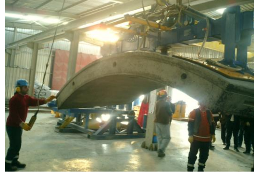
Şekil 6: Segmentlerin kalıptan çıkması
