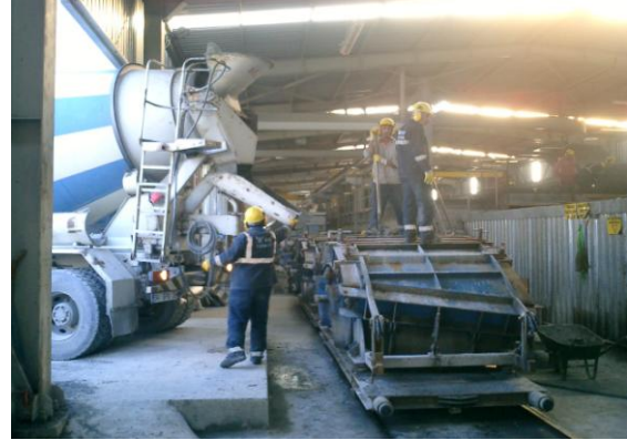
Şekil :2 Betonun dökümü
