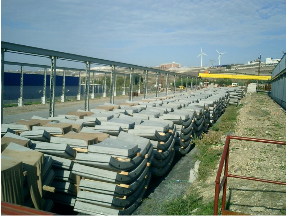
Şekil 7: Segmentlerin stoklanması
