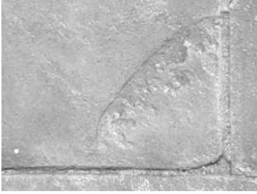
Şekil 6. Korunan beton yüzeyi.
